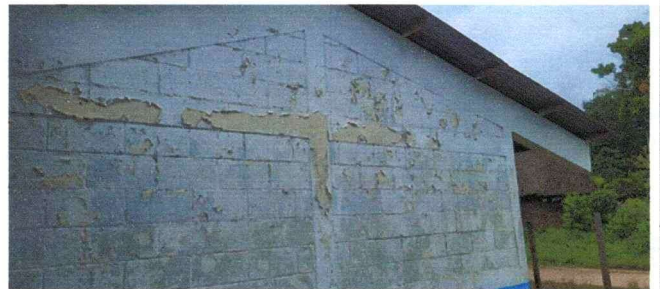
Foto 6: se observa el deterioro de pintura del establecimiento.
