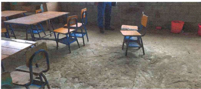
Foto 5: se necesita reparación de piso de un aula, porque esta en malas condiciones.
